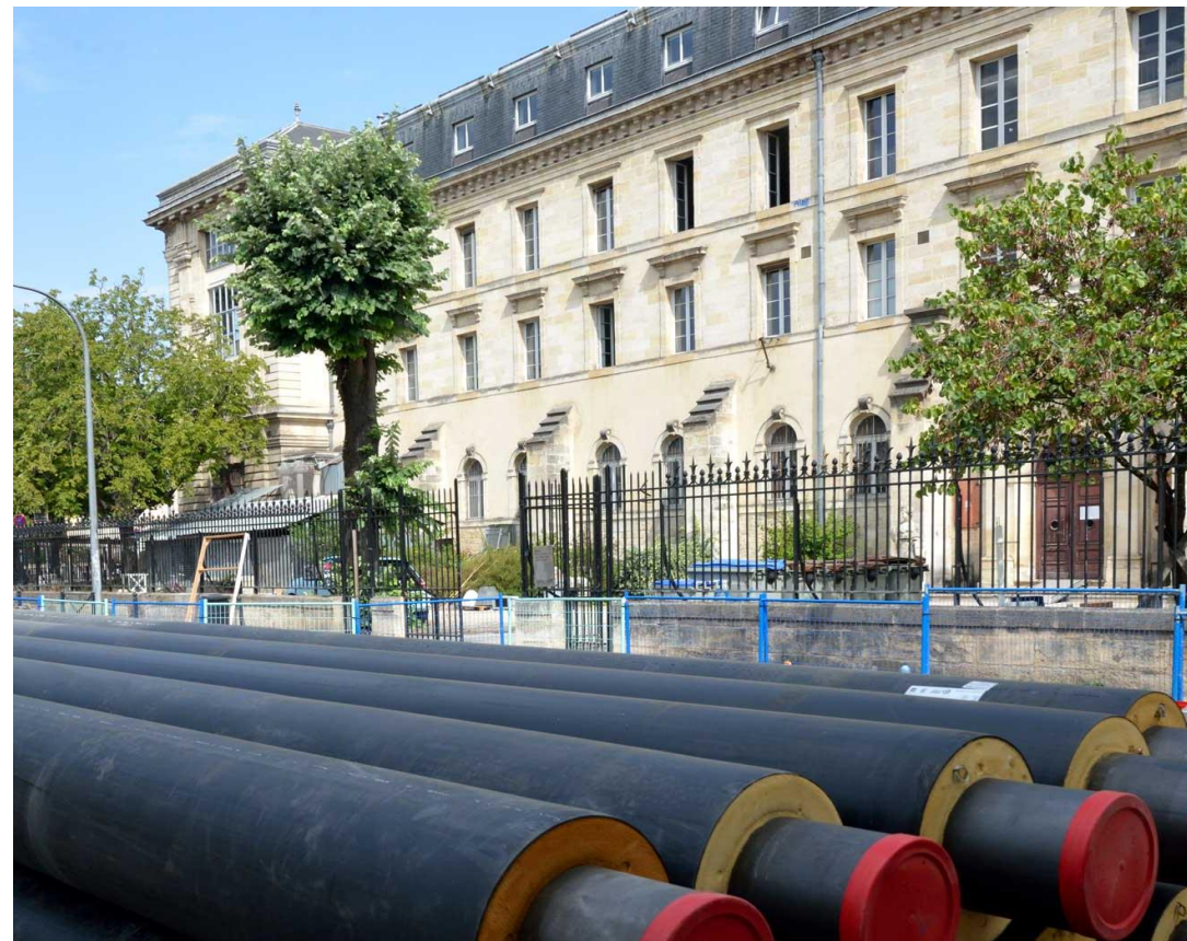
Des tuyaux calorifugés
